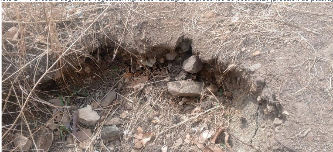
Photo E — Trou d'excavation abandonné — l'un des 703 trous recensés (érosion, perte de terres, risque).
