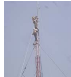
Assemblage du pylône
