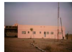
Bâtiment abritant la RASAL
