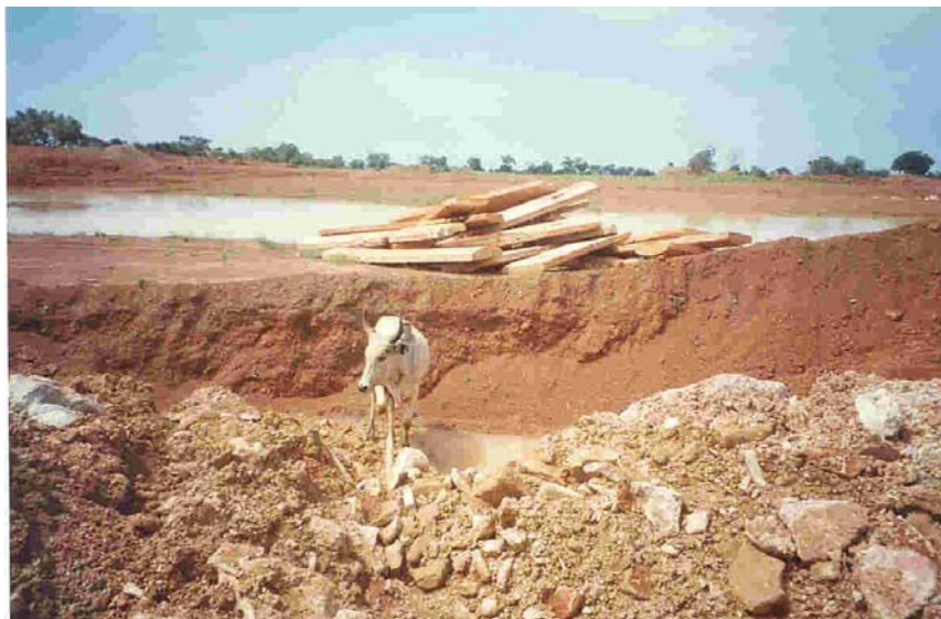
Formation d'un important plan d'eau et vue de débris de construction déversés au niveau de la carrières à Beroll
